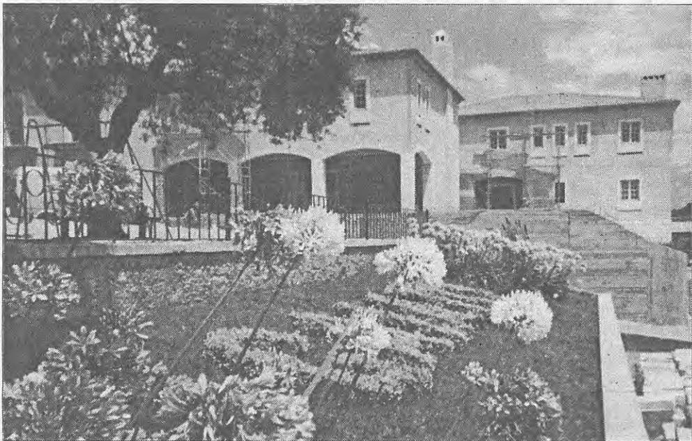
Casa do Gaiato de Miranda do Corvo — Edifícios novos com jardim à frente.
